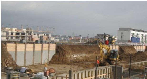
Abb. 5 : 60 m Baugrubenverbau Frankfurt Riedberg
