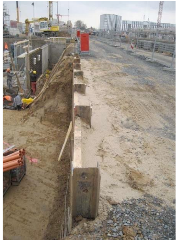
Abb. 2 : Holzausfachung im oberen Bereich
