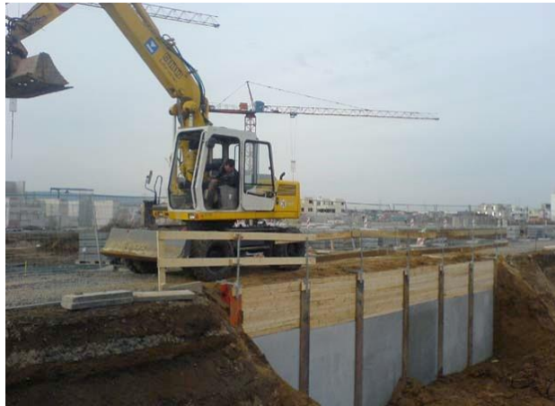
Abb. 3 : Trägerbohlwand mit Holzausfachung und Stahlbetonfertigteilen bei 3,6 Metern Baugrubentiefe nimmt zusätzliche Verkehrslast eines 16 Tonnen-Baggers sicher auf
