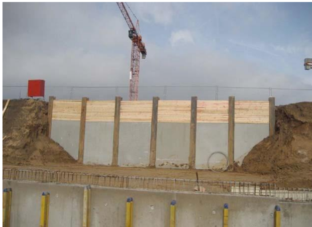
Abb. 4 : Trägerbohlwand mit 2,4m hohen Betonfertigteilen
