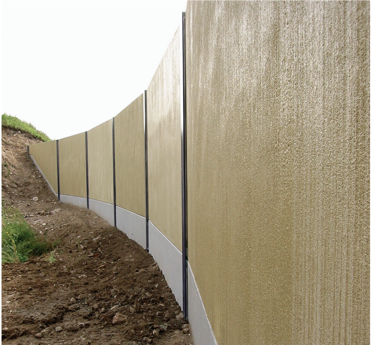
Beidseitig reflektierende Betonwand
